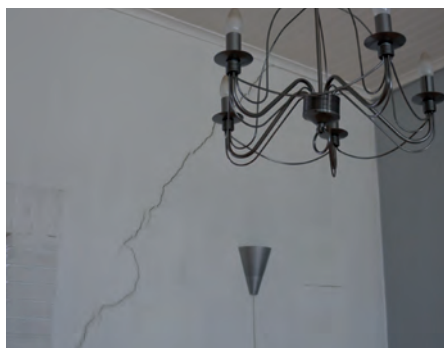
Zbutwiałe okna, pękające ściany, rozstępująca się podłoga i znaczny przechył budynku uniemożliwił bezpieczne przebywanie w lokalu.
